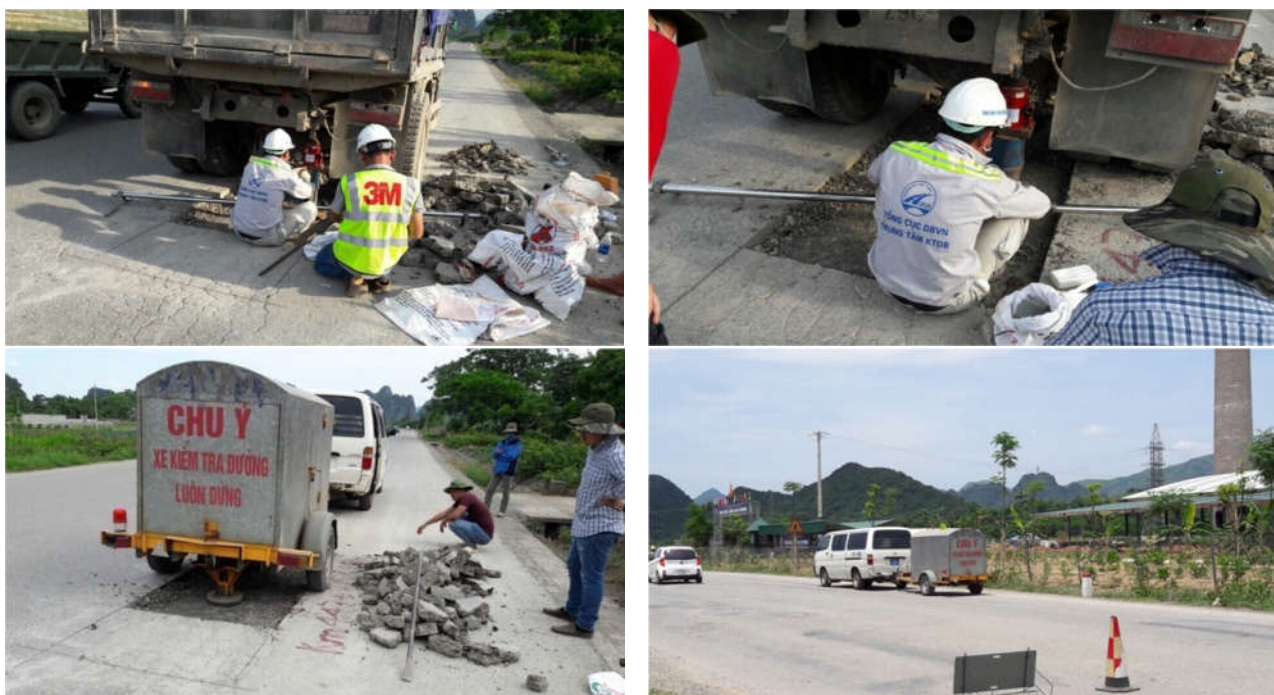
Hình 2. Công tác đo vồng bằng FWD tại hiện trường
