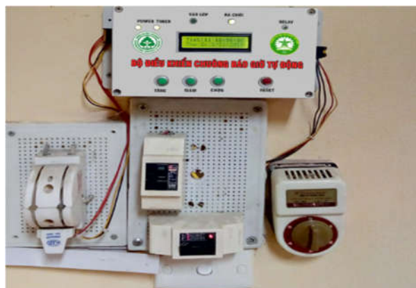
Hình 12. Kết quả lắp đặt bộ điều khiển
